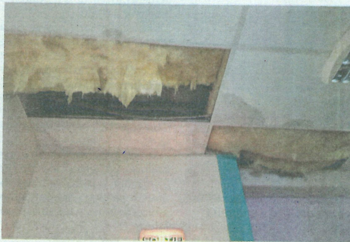
Deux plaques des faux plafonds ont cédé sous le poids de la laine de verre imbibée d'eau. PHOTO MAIRIE PORT-DES-BARQUES
