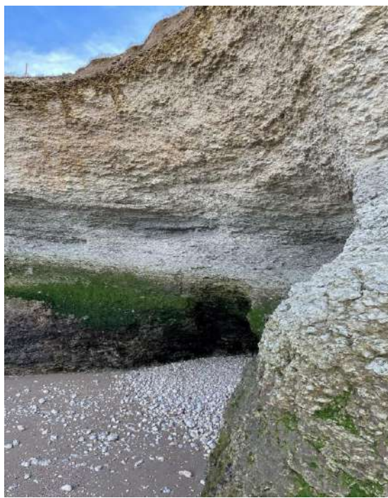
Figure 21. Érosion de la falaise nord de l'île Madame, photographie prise en novembre 2021
