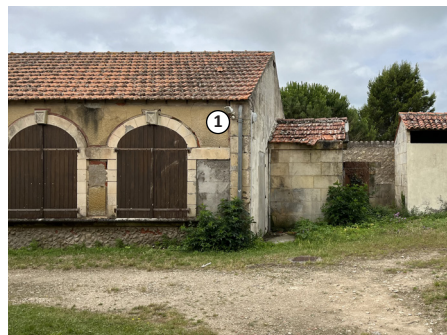
Une construction faite de matériaux disparates : moellons, pierre de taille, brique monobloc, enduit...
