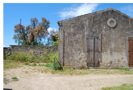
La salle de musique : bâtiment surélevé et proximité avec le mur du sanctuaire.
